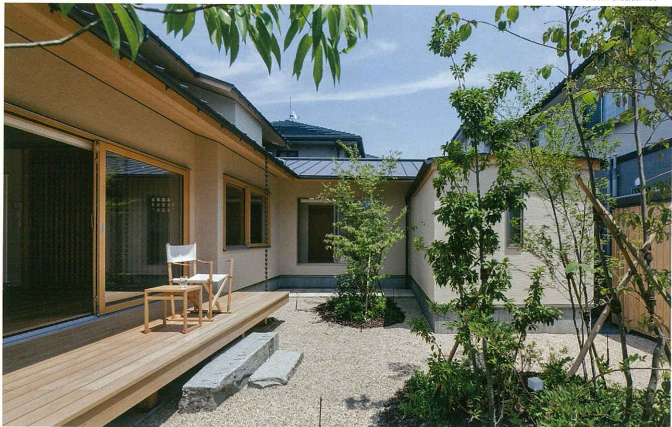
〈暖かい終の住処〉 愛媛県 設 計:奥野崇建築設計事務所 施 工:もみじ建築 撮 影:小川 重雄 雨といスタンダード半丸105(ガンメタ) 丸たてとい60φ(ガンメタ) クサリトイ ensui(ガンメタ)
